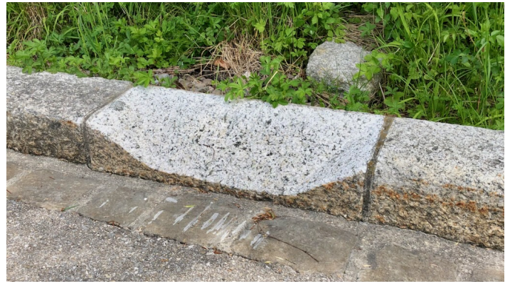
Bordure abaissée pour les amphibiens en migration en ville de Lausanne. Photo : M. Di Giulio
